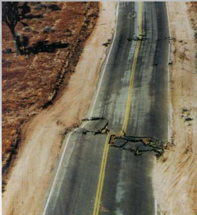
Desplazamiento dextral en una calle a raíz del terremoto de Landers (M 7,3)
